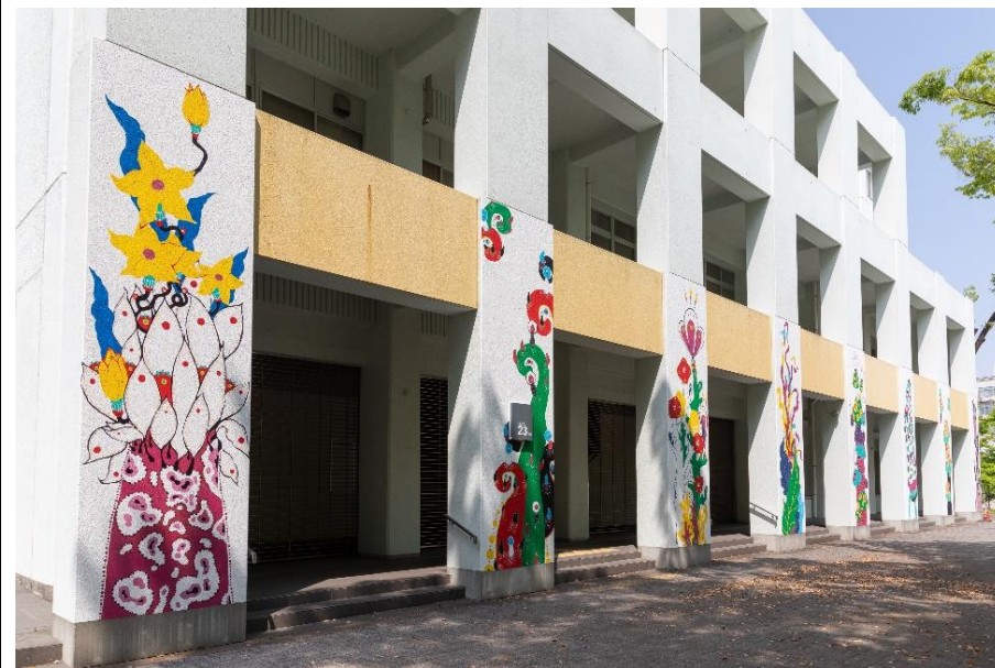
『砂漠のガーデン』（TEIYOUYOU+岩間研究室 作）23号館外壁
